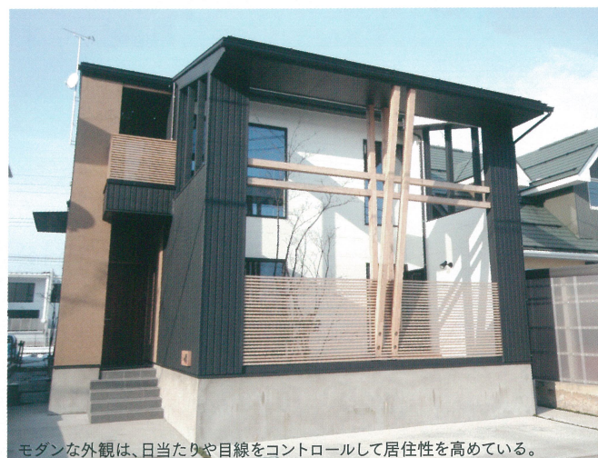
モダンな外観は、日当たりや視線をコントロールして居住性を高めている。
